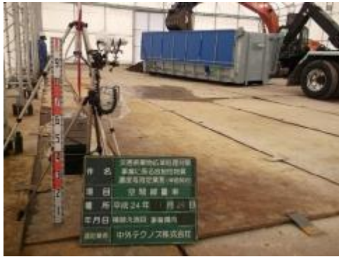
<作業場内の測定（No.①地点）>
