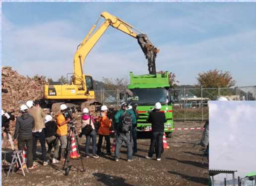
積込みの様子
