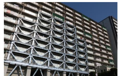
建物の耐震補強の様子
