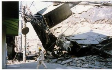
倒壊し道路を塞ぐ建築物
