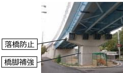
橋梁の耐震補強の様子
