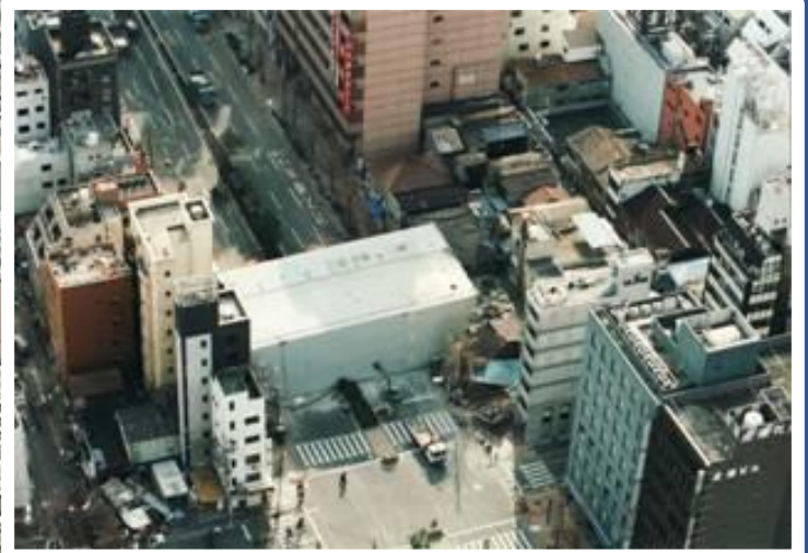
阪神・淡路大震災で倒壊し道路を閉塞したビル
