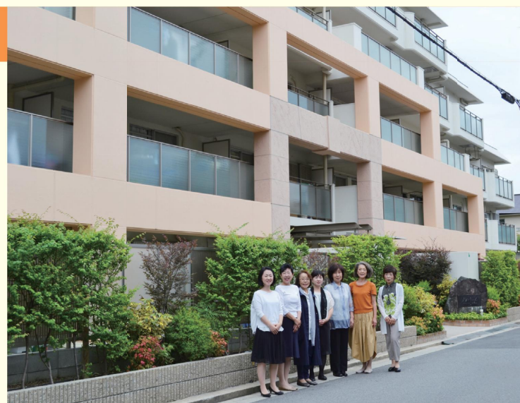
専門委員会の皆様とアウトフレーム工法による耐震改修工事を行った外観写真
