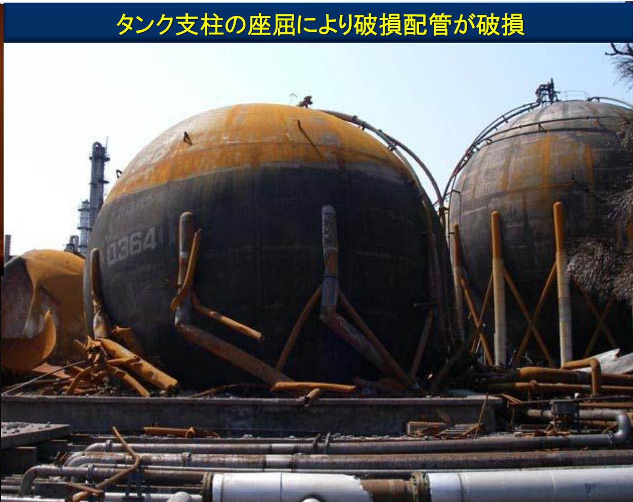
タンク支柱の座屈により破損配管が破損
