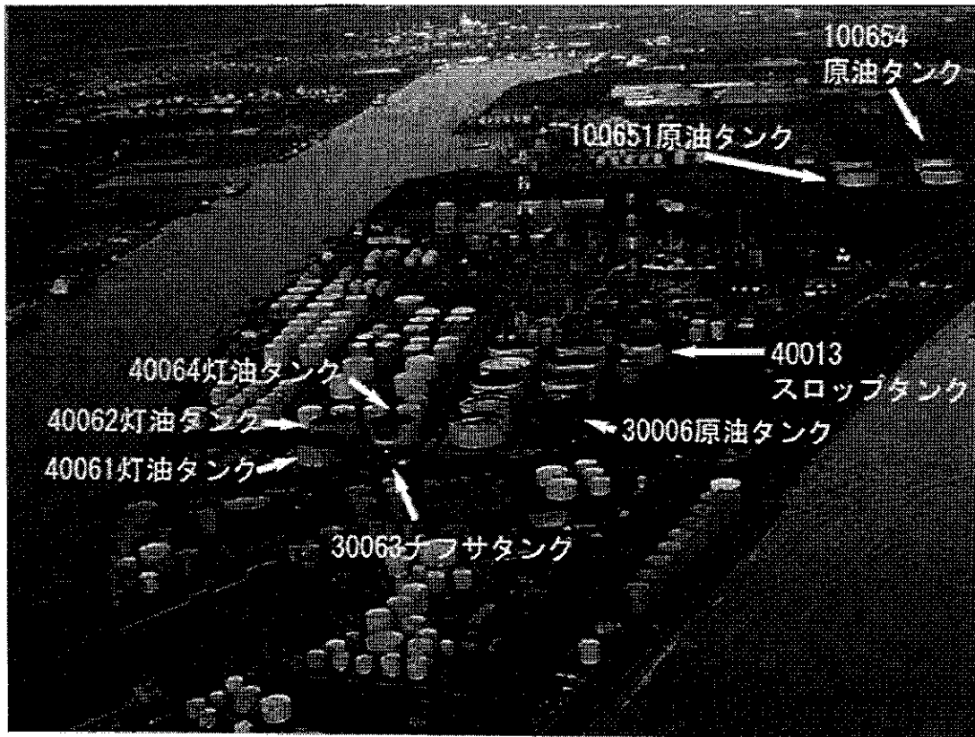
写真 5.1 出光興産北海道製油所全景 10)
