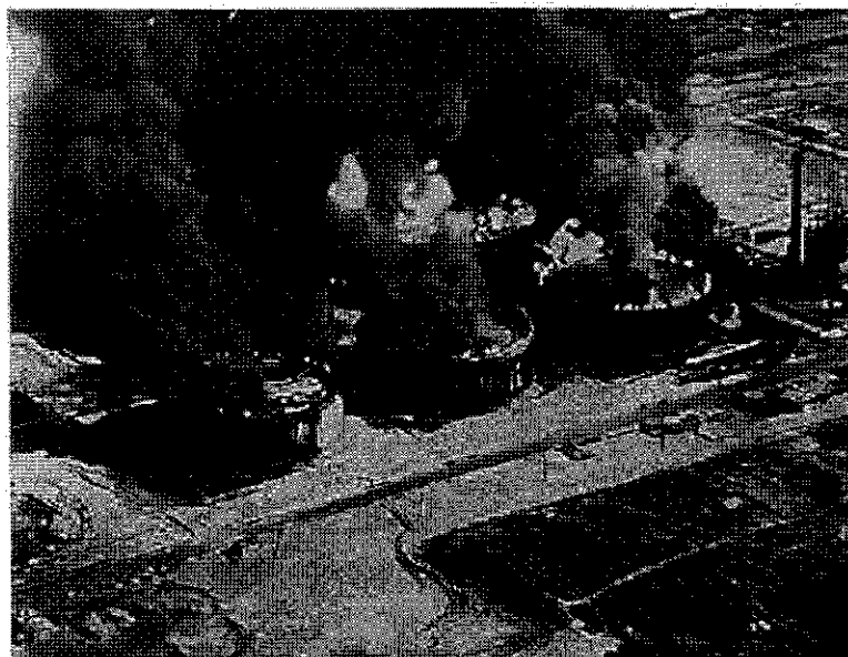
発災当日(6月16日)午後9時のタンクの燃焼状況 地震の際タンクからあふれ出た油は暴走発生
