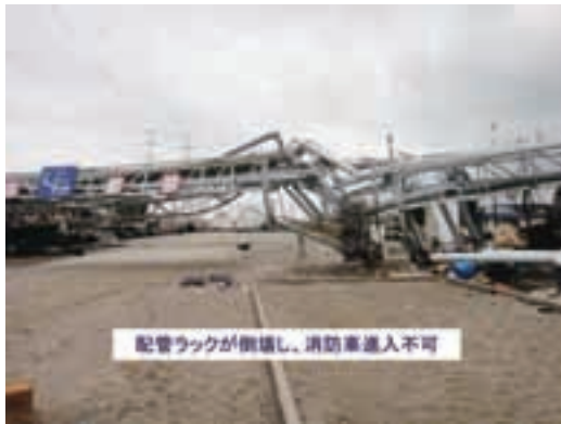
図3 西地区への進入道路
