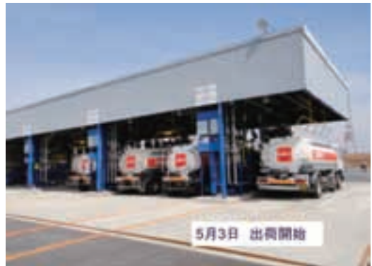
図7 東地区仮設ローリー積場
