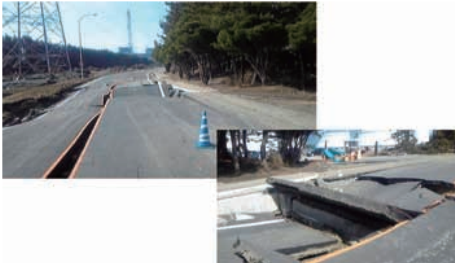
図4 製油所進入道路の様子
