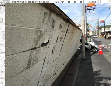
(新)大阪高槻京都線 コンクリート 高架橋 コンクリート剥離 (茨木市野々宮)
