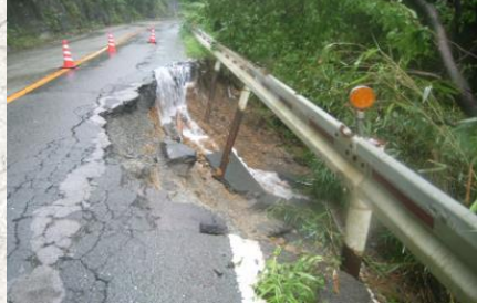
萩谷西五百住線 法面崩壊(高槻市萩谷月見台)
