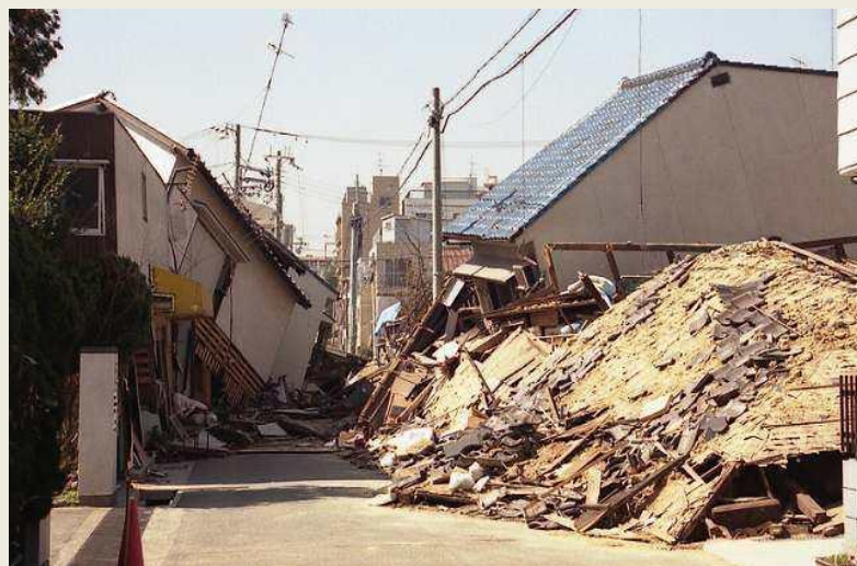
住宅倒壊による道路閉塞（阪神淡路大震災）
