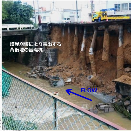
法面土砂崩壊 府道 岸和田牛滝山貝塚線 岸和田市大沢町
