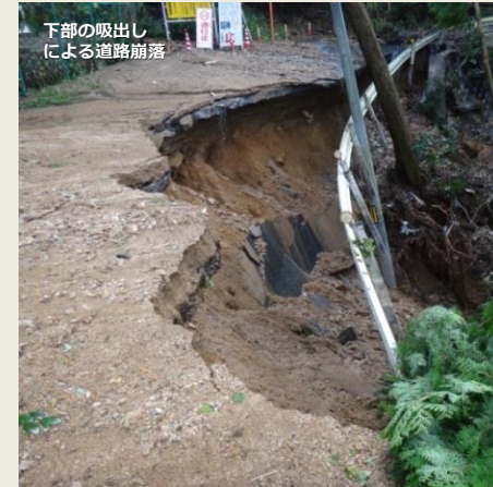
法面土砂崩壊 府道 岸和田牛滝山貝塚線 岸和田市大沢町
