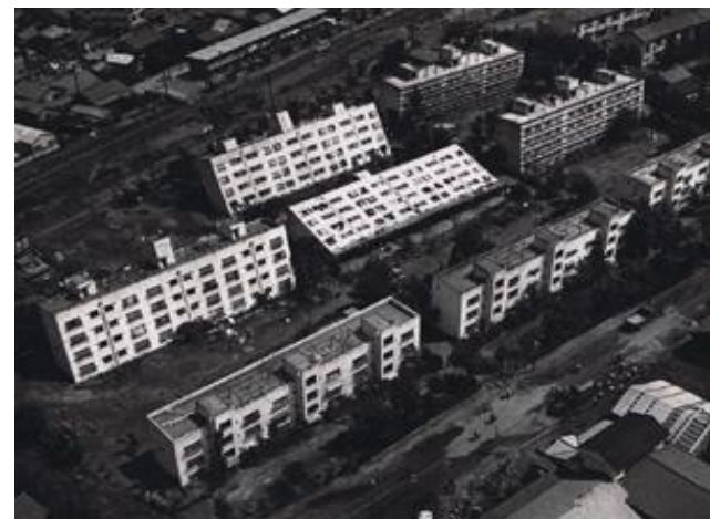
マンションの倒壊（新潟地震） 出典）新潟市HP
