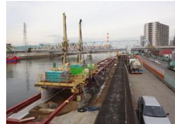
施工中 (地盤改良工事)
