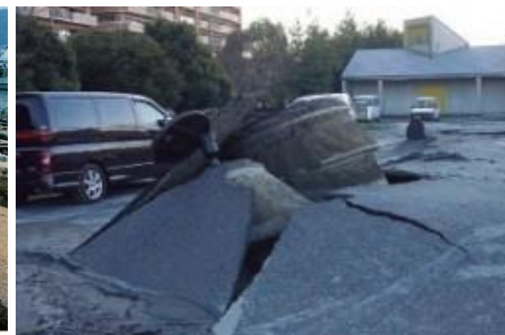
マンホールの浮上り（東日本大震災） 出典）浦安市HP
