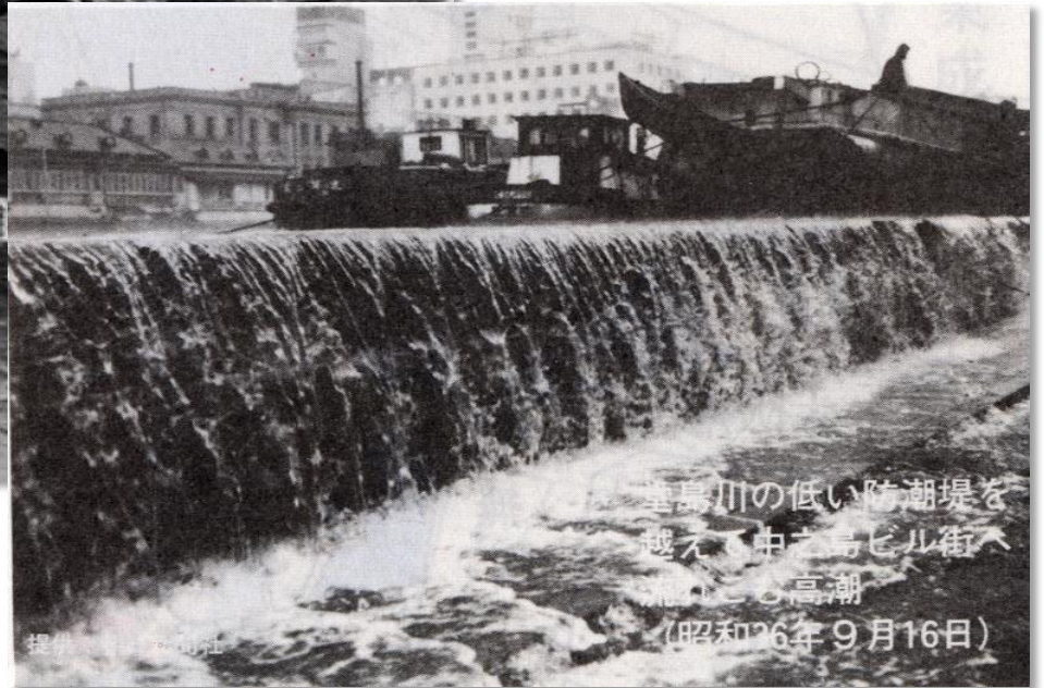
第2室戸台風による被害状況 大阪市北区中之島
