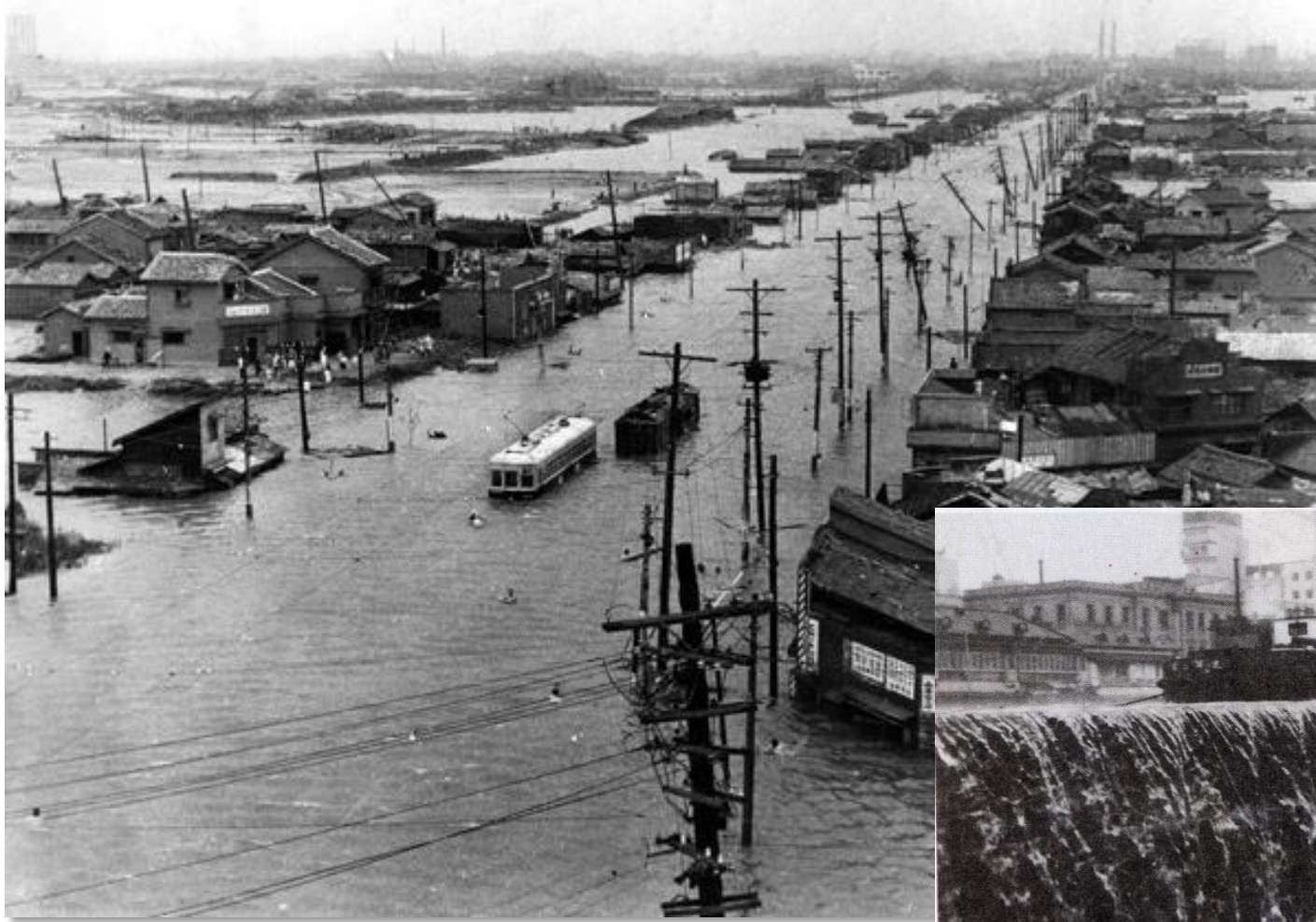
ジェーン台風による被害状況 大阪市港区市原付近
