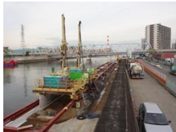
施工中（地盤改良工）
