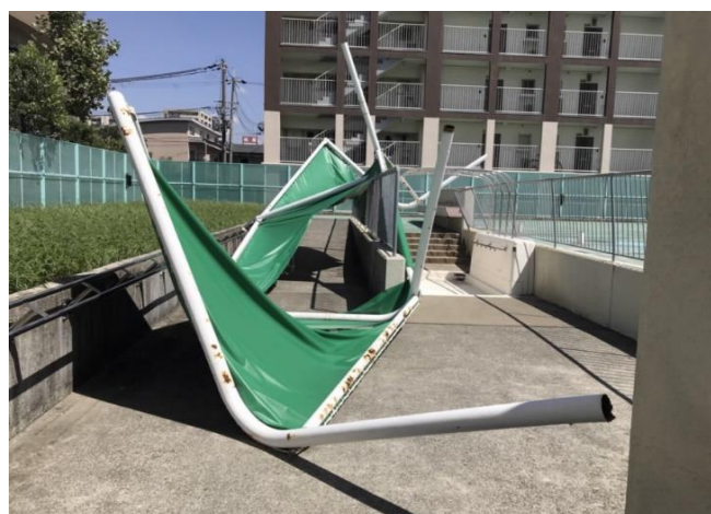
高槻市立高槻小学校（プール日除けの倒壊）
