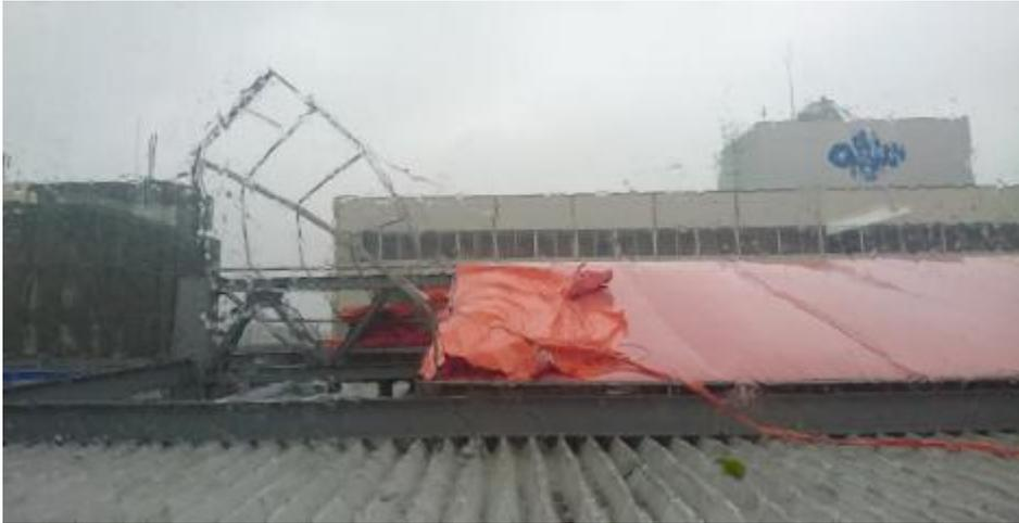
②青果棟屋根部分損傷 ⇒ 大果事務所の屋根部分のため、事務所内に雨漏り多発
