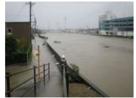
平成21年台風18号による高潮浸水の様子
