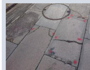
【蓮池周辺本石舗装】
