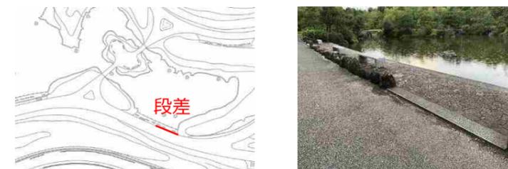
【方針】： ・原則、段差は、2cm 以下となるよう、取外し再設置する。
