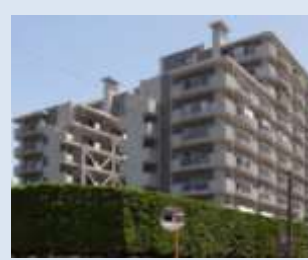
耐震改修済み
