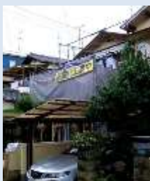
耐震改修工事中
