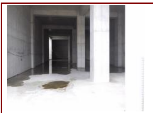
写真③ 沈砂池棟北側(躯体完了)
