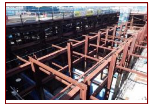
写真⑤ ポンプ棟Ⅰ期(B1F床版、仮壁迄完了)
