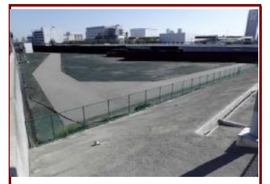
写真⑦ 下水ボックス(完成)(地上部)
