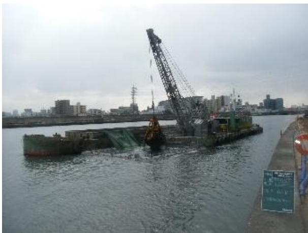
神崎川河床掘削工事
