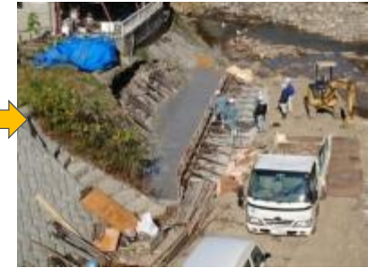
崩壊護岸にコンクリートを打設し、安全性を確保。
