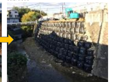
応急対応の大型土のうを設置し決壊防止対策を図る
