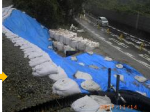
応急対策工事を完了し片側交通開放
