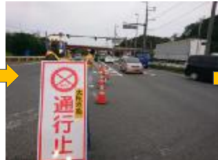
応急対策工事が完了するまでの間の交通規制対応
