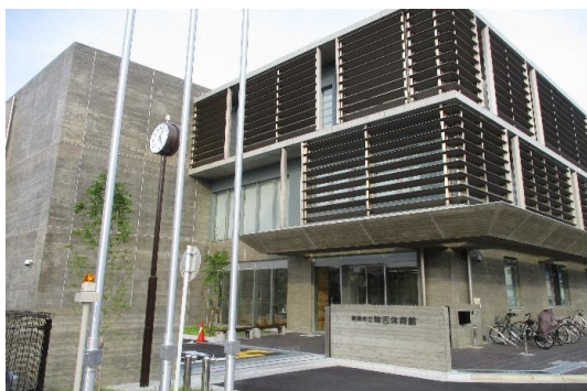
マンホールトイレ・かまどベンチの設置
