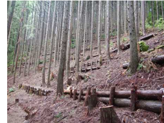
本数調整伐と筋工の施工
