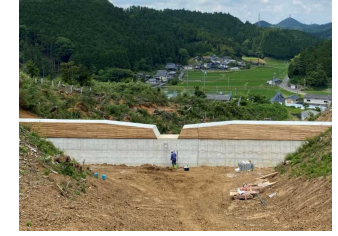
堆砂容量のある治山ダムの設置
