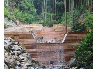
小規模治山ダムの階段状配置
