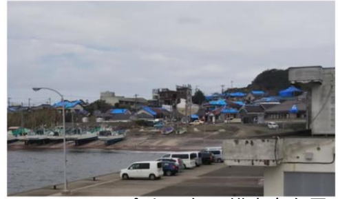
令和元年房総半島台風 (気象庁職員撮影)
