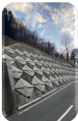
平通阪井峠線（擁壁）
