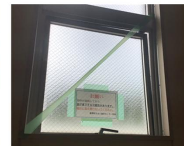
プールとの仕切り擁壁の沈下 階段踊り場の窓が開閉不可 その他、建具の不具合箇所多数あり
