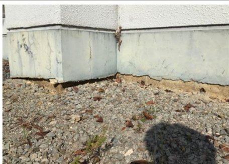
玄関右側壁面にクラック(複数箇所)
