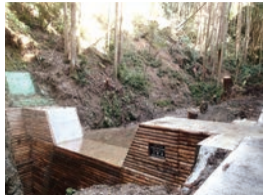
危険渓流の流木対策の様子
