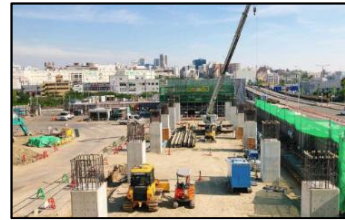
北大阪急行延伸 箕面萱野駅付近
