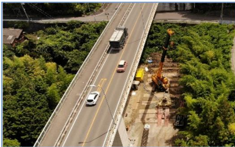
国道170号 (4車線化)
