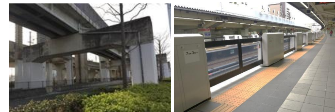
鉄道施設の耐震補強
