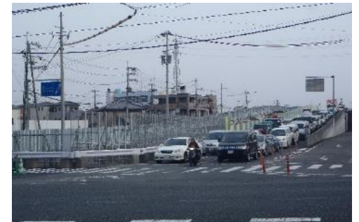
立体交差化事例(事業中) 府道茨木亀岡線 西河原西交差点(茨木市)
