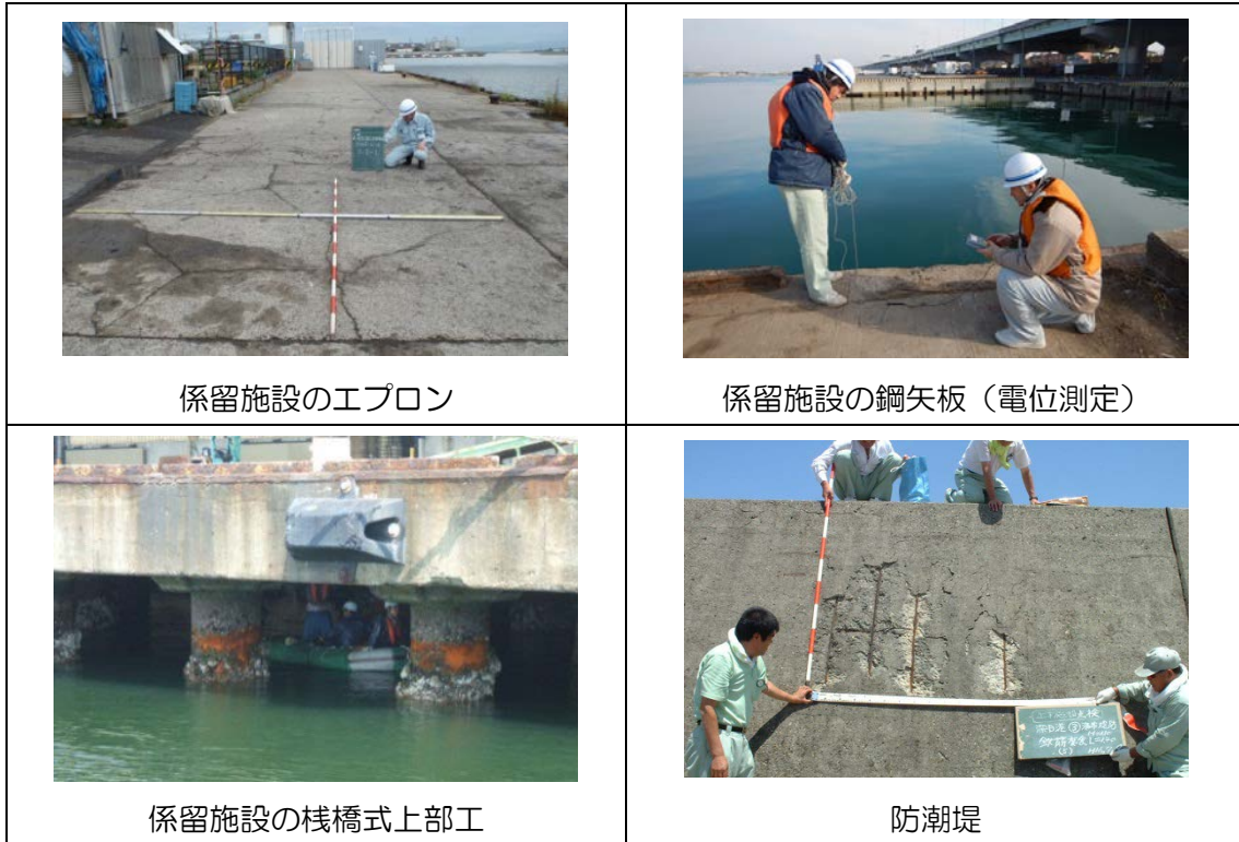
写真 2.2-1 一次点検（職員）の現状
