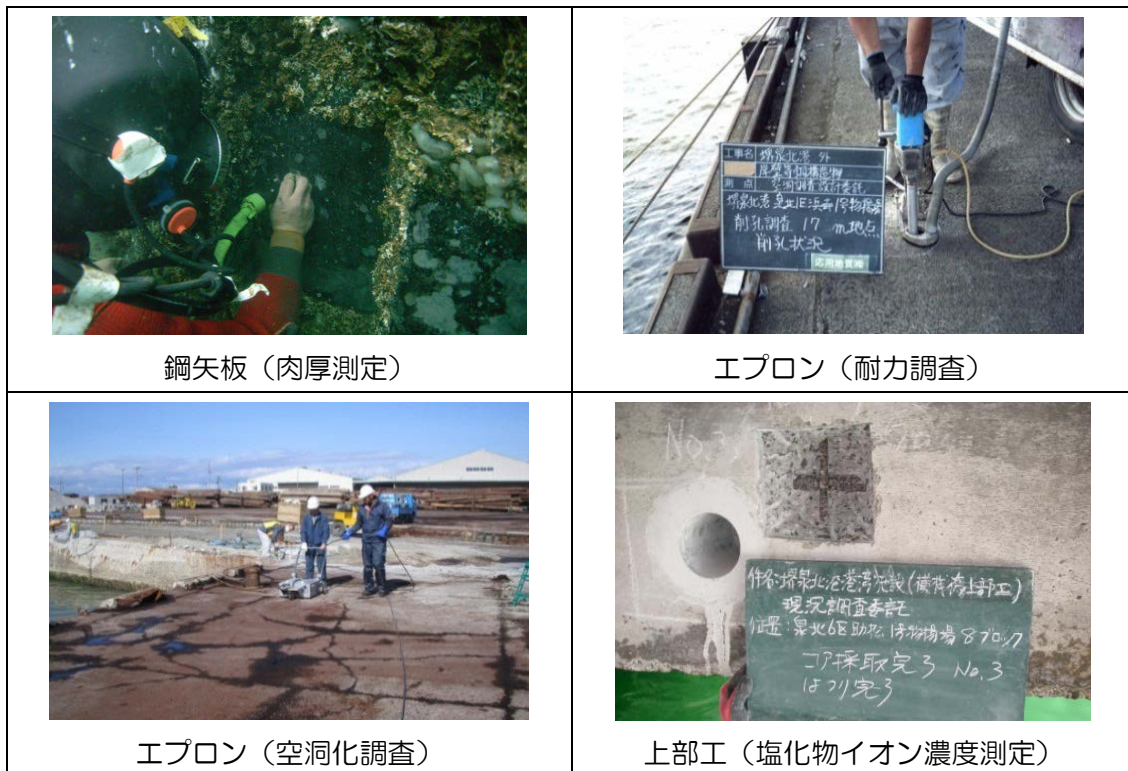
写真 2.2-2 二次点検（専門家）の現状
