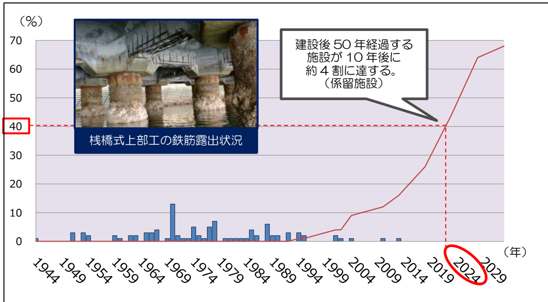
図 2.1-2 港湾施設（係留施設）の経過年数
