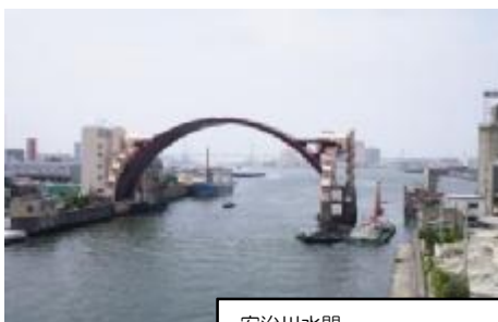
安治川水門 (昭和45年完成 大阪市港区)
