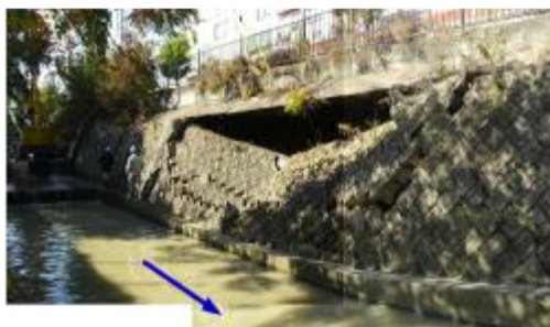
写真 2.1-6 護岸の崩壊
