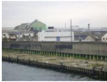
特殊堤（コンクリート）
