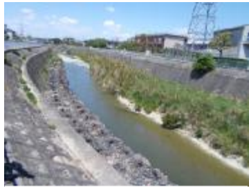
護岸（特殊堤を除く）
