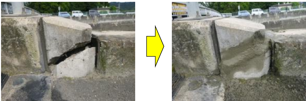
写真 4.5-2 直営作業による補修（橋梁地覆取付け部のモルタル処理）
