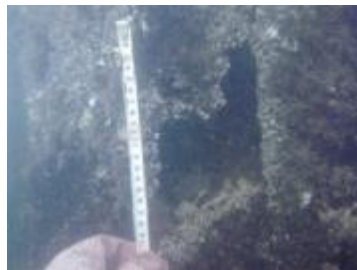
鋼材の貫通孔（水中部）
