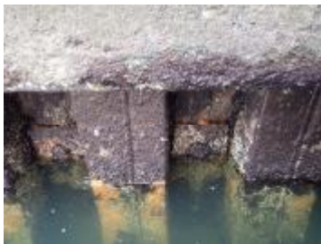
鋼材の腐食
