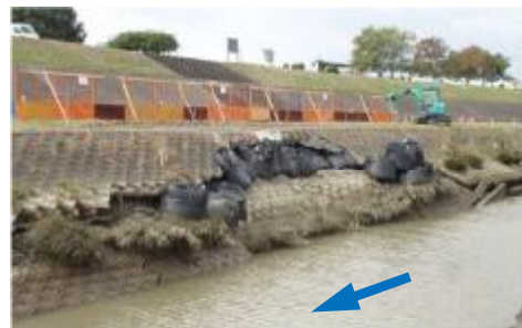
写真 2.1-6 護岸の崩壊
