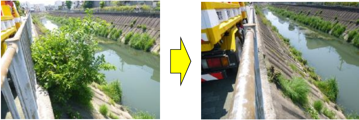
写真 4.5-4 直営作業による雑木の伐採
