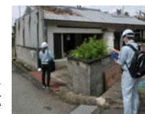
解体工事現場指導(建設リサイクルパトロール)
