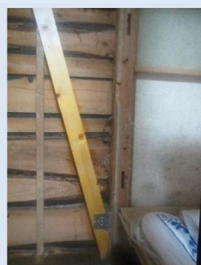
金物と筋かいの設置
