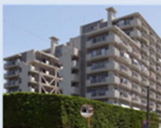
耐震改修済み
