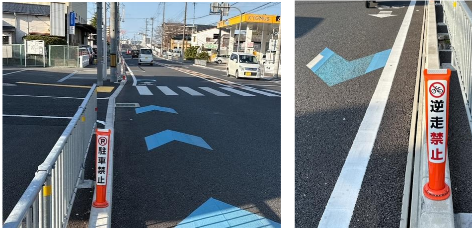
図 16. 駐車禁止逆走禁止喚起ラバーポール設置事例
