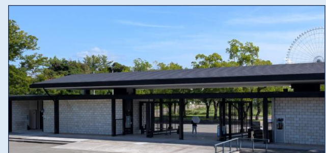
《参考》屋根改修後 4号棟（正門）
