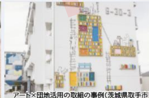
アート×団地活用の取組の事例(茨城県取手市)
