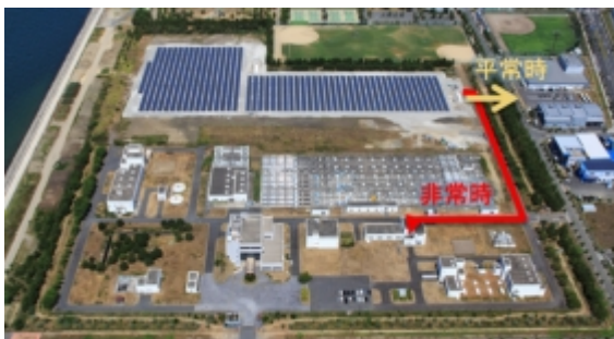
湾岸南部水みらいセンターに設置されたソーラーパネル
