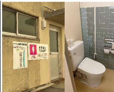
上屋附属事務所 女性トイレの設置
