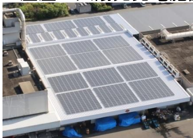
👉 上屋屋上太陽光発電施設
