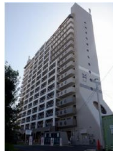
耐震改修(一例)
