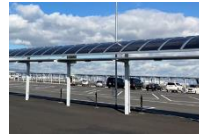
バスシェルターへの ペロブスカイト太陽電池の設置 提供：積水化学工業株式会社
