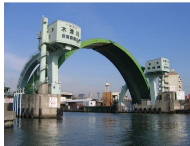
木津川水門 昭和45年11月完成
