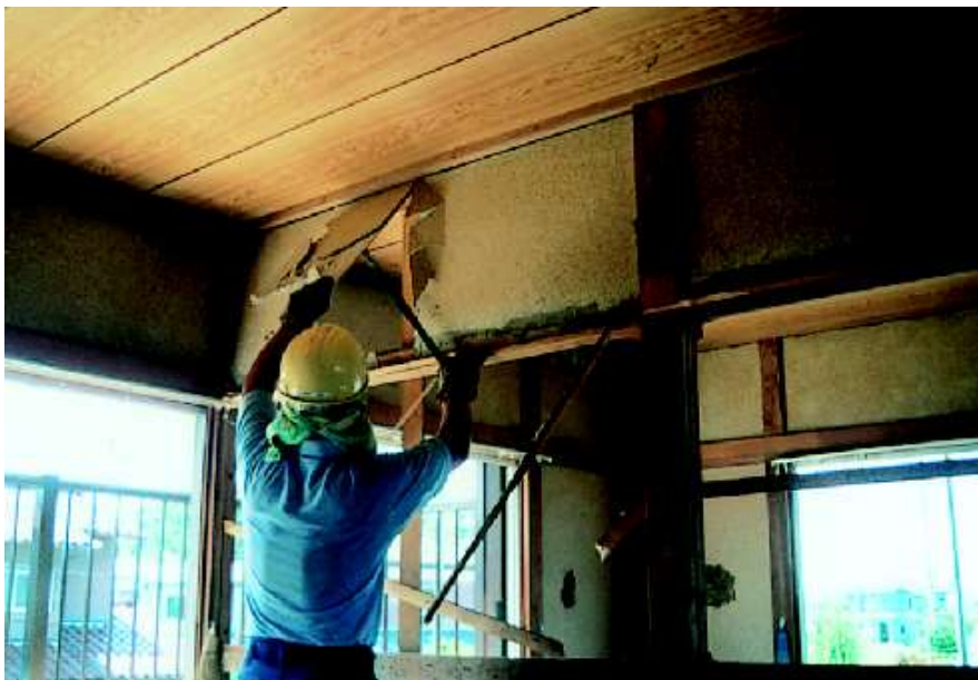
内装材の取り外し
