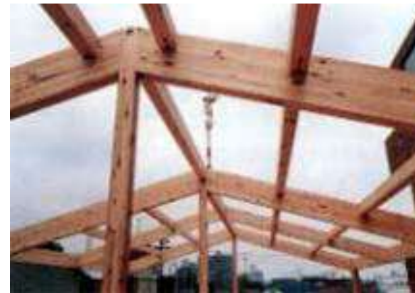
建設発生木材を特殊加工したものをういて、住宅用構造 材等に利用することのできる木質建材を製造する技術。 (メーカー資料より引用、写真は一例)
