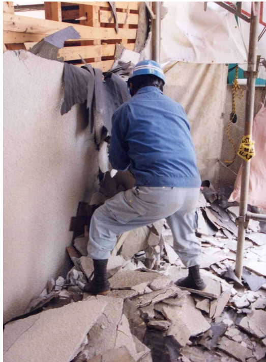
外装材の取り壊し
