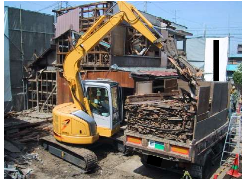
建設発生木材の搬出
