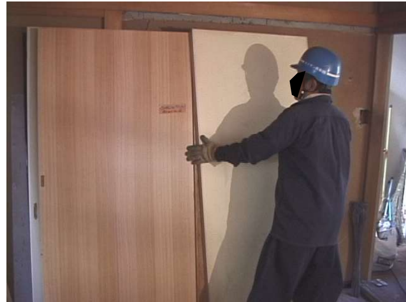
建具の取り外し
