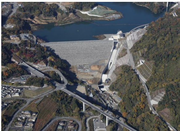
安威川ダム建設事業
