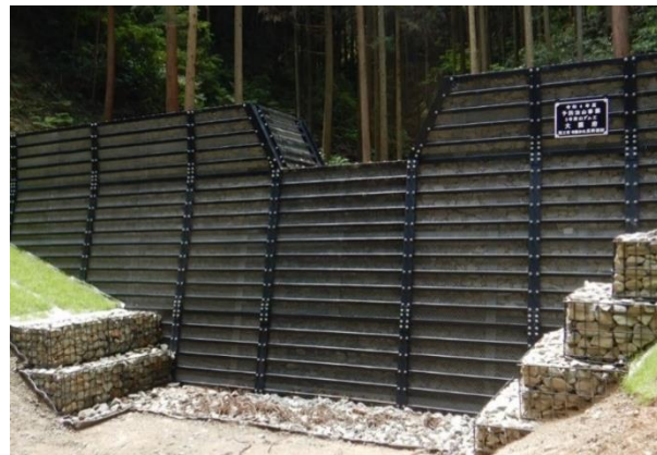
治山事業 (河内長野市大井地区)
