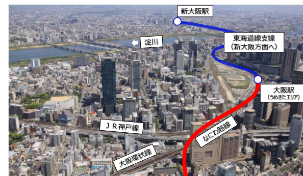
なにわ筋線(大阪駅付近)
