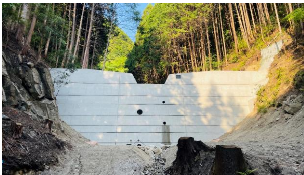
治山ダム（流域治水対策型）の整備
