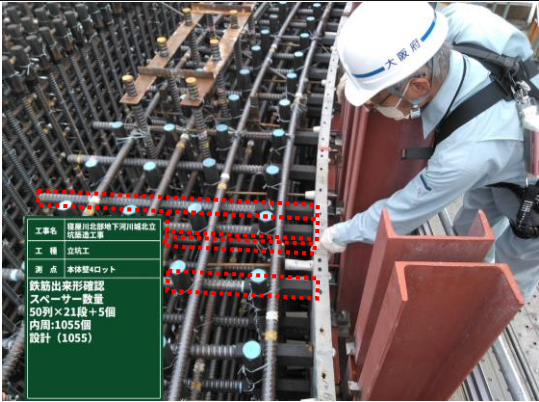
図 ケーソン内の機械式接手施工写真
