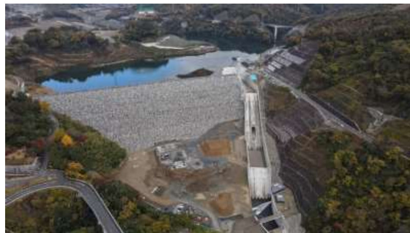
安威川ダム建設事業 (茨木市)
