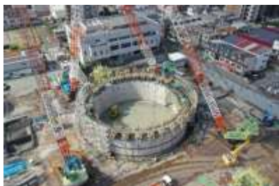
寝屋川北部地下河川(城北立坑) (大阪市)
