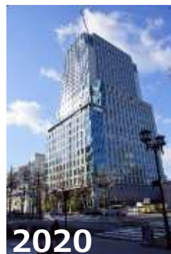
⑤オービック御堂筋ビル 高さ：約116m (地上25階/地下2階) 竣工：2020.3開業 用途：オフィス・ホテル複合 導入：飲食、ショールームなど 備考：大阪初進出 サロイヤールパークホテル
