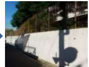
府立学校の改修例 (改修後)
