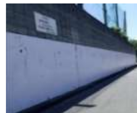
府立学校の改修例 (改修前)
