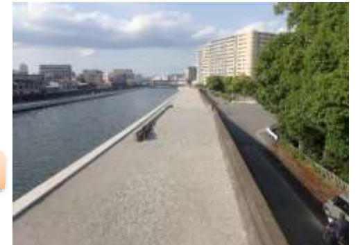
一級河川 六軒家川 防潮堤補強【対策後】
