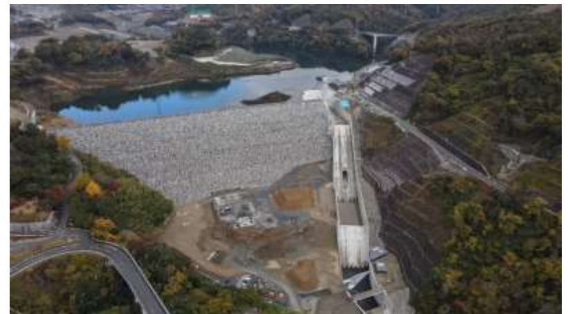
安威川ダム建設事業 (茨木市)
