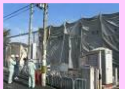
アスベスト解体現場パトロール
