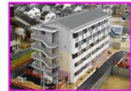
改良住宅（生野東住宅2号館1期棟） 平成24年3月 完成（22戸）
