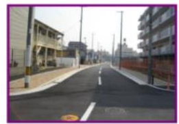
主要生活道路（生野東西線） 平成25年3月・平成26年3月 完成（延長約300m）
