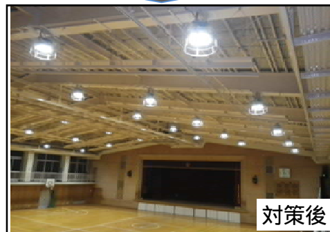
写真 学校施設の屋内運動場の脱落対策(吊り天井撤去の例)
