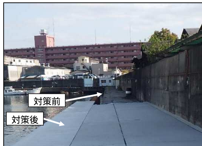
写真 防潮堤の耐震・液状化対策工事の実施状況
