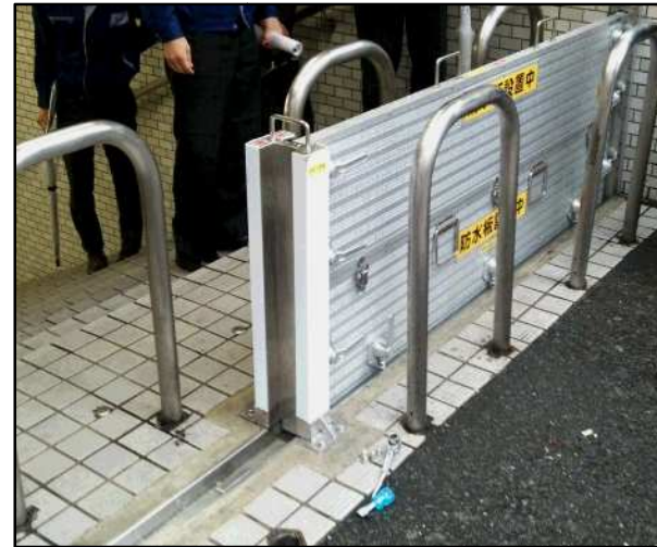
写真 地下街出入口部の止水板の設置状況
