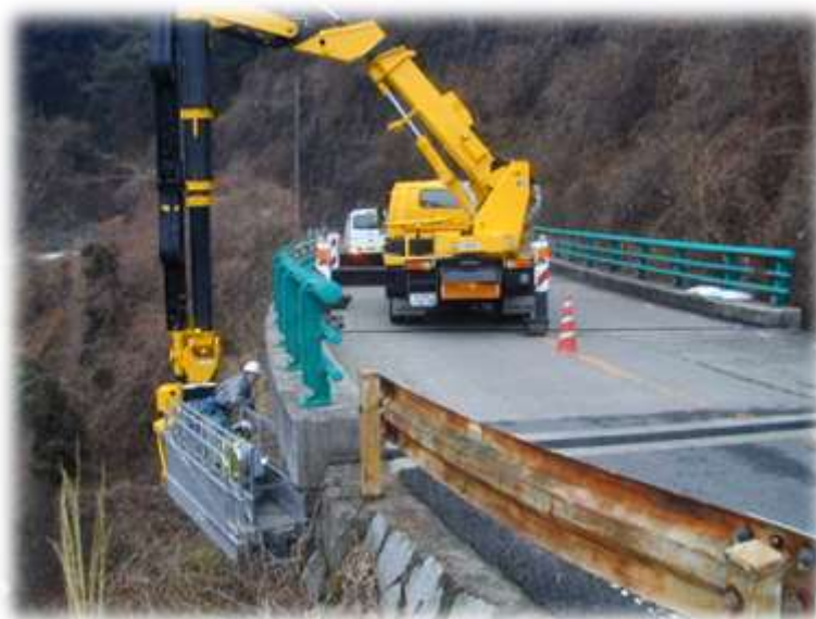
図 4.1-2 作業車での点検風景
