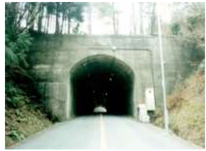
野間隧道（1936年建設 開削工法）
