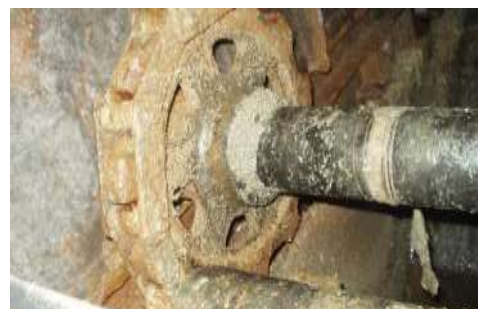
錆発生および腐食摩耗
