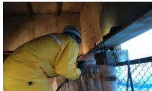
橋梁補修：普段立ち入れない現場
