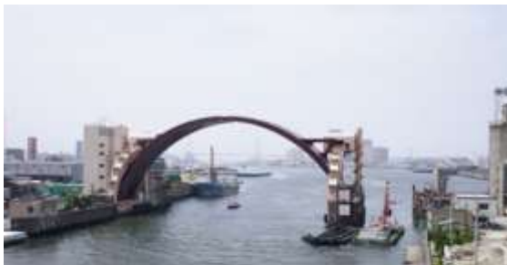
水門：普段近寄れない都市基盤施設
